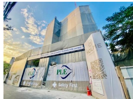
ภาพที่ 2.2-4 รั้วชั่วคราว (Metal Sheet) และประตูเลื่อนผ้าใบ
