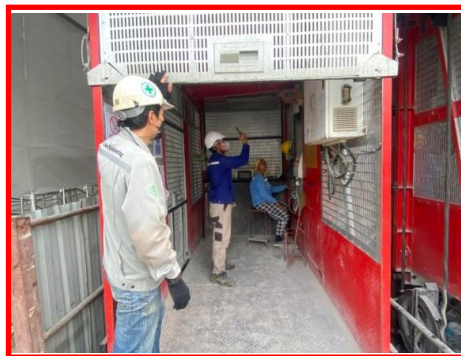
ภาพที่ 2.2-36 ลิฟต์โดยสารและขนส่งวัสดุชั่วคราว
