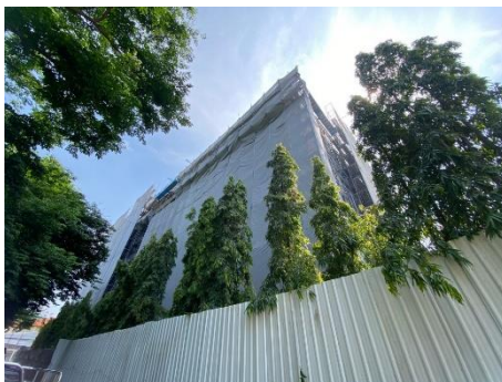
ภาพที่ 2.2-4 รั้วชั่วคราว (Metal Sheet) และประตูเลื่อนผ้าใบ
