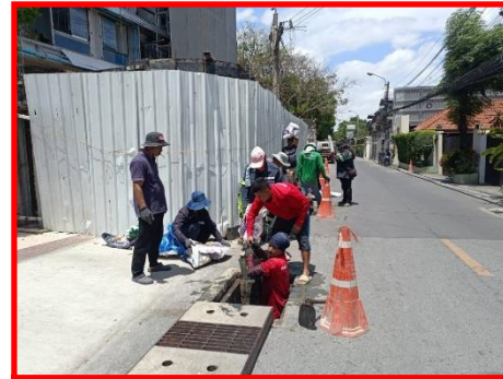
ภาพที่ 2.2-21 การขุดลอกท่อระบายน้ำสาธารณะ
